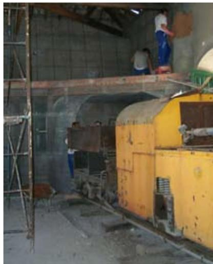
Vagón de Vuelco Simple tipo B<sub>2</sub>, durante su instalación en la Sala nº 12
