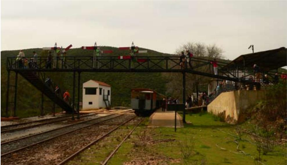
Portico de Señales tipo Stevens instalado en el paso peatonal elevado en la estación de Los Frailes, año 2009, Foto ADD.
