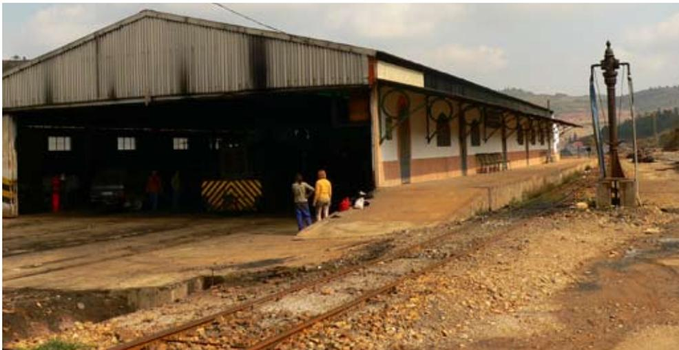
obsérvese el surtidor de agua para las locomotoras de vapor, año 2009. Foto ADD.
