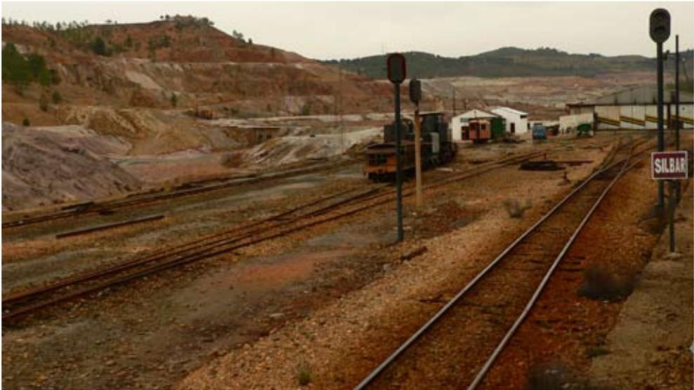
Semáforos de iluminación eléctrica reproducidos en funcionamiento junto a la estación de Zarandas, obsérvese también la señalización vertical y el sistema de cambio y cruzamiento, año 2009. Foto ADD.
