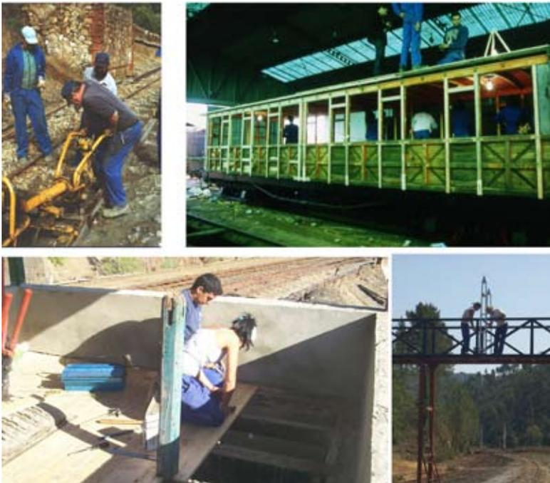
Distintas labores de rehabilitación desarrolladas mediante programas formativos: Tendido férreo, Restauración de Parque Móvil remolcado y Casa de Palancas Norte y Construcción del Puente peatonal elevado de Los Frailes. Fotos A.F.R.T.
